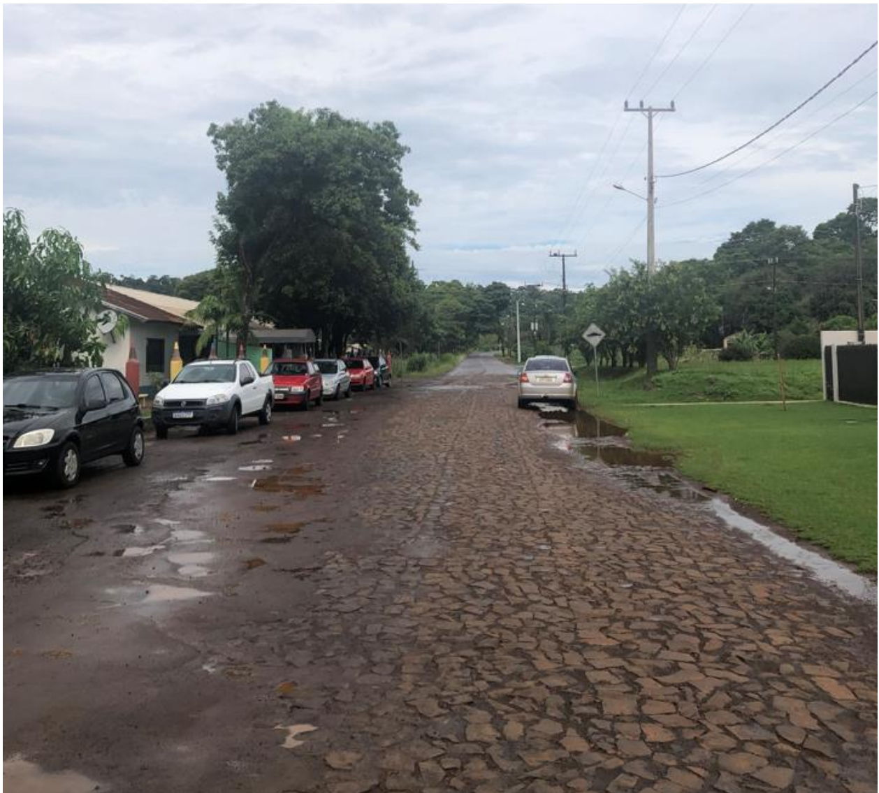
FIGURA 6.55 – ESTADO DE CONSERVAÇÃO DO PAVIMENTO NO MARALÚCIA
