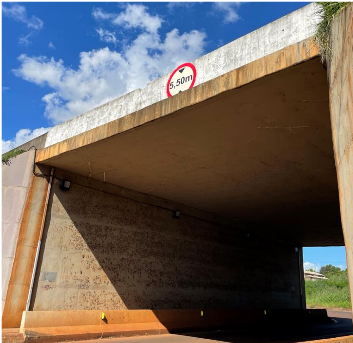
FIGURA 6.66 – VISTA DO ENCONTRO – TRINCHEIRA JARDIM IRENE
