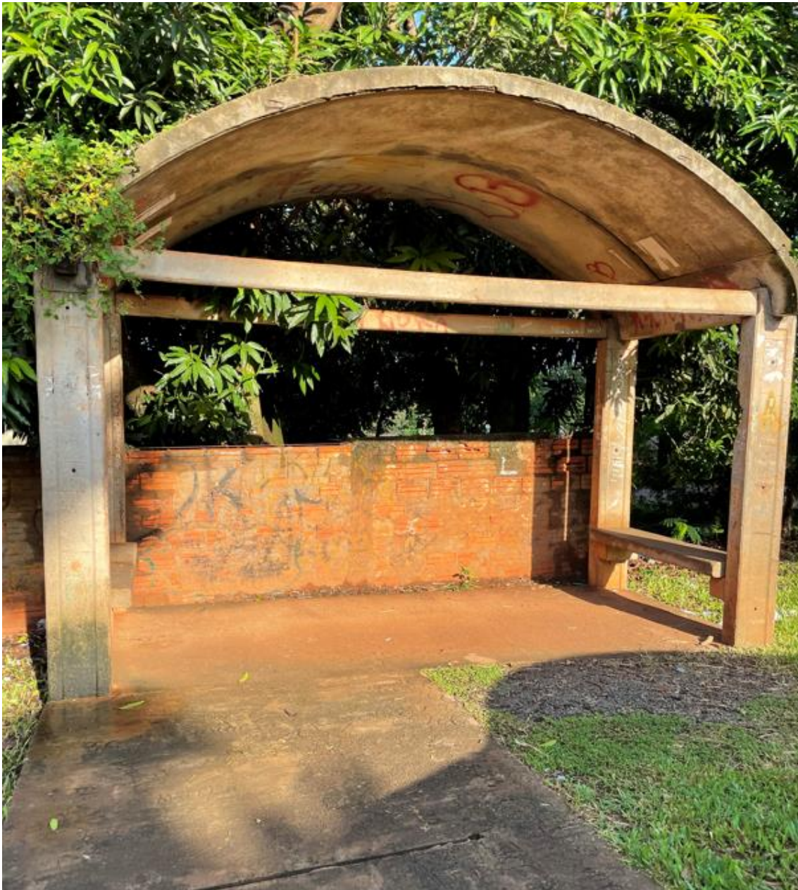
FIGURA 6.130 – CONCRETO COM COBERTURA DE CONCRETO
