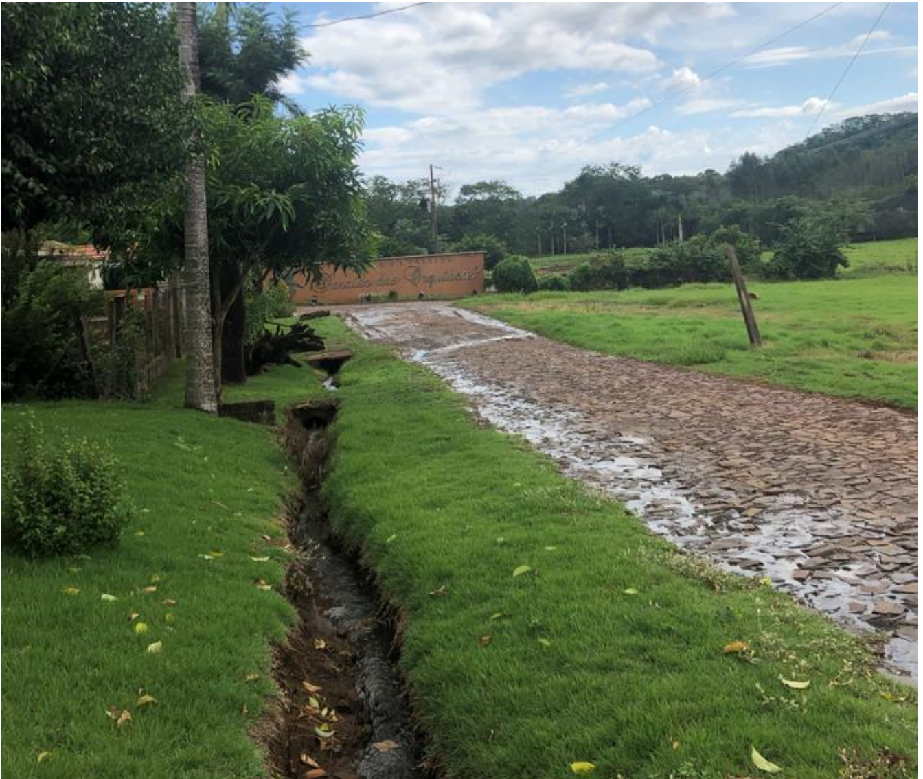
FIGURA 6.54 – CANALETA DE DRENAGEM EXECUTADA POR MORADORES
