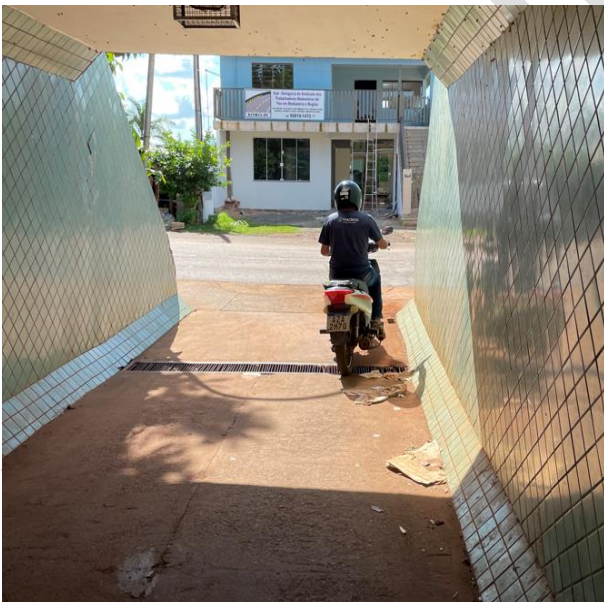
FIGURA 6.79 – MOTO ATRAVESSANDO NA PASSAGEM
