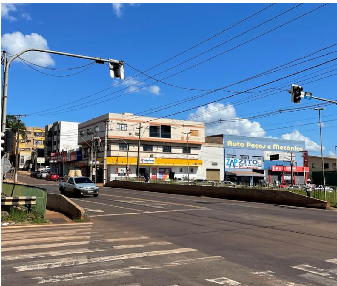
FIGURA 6.75 – VISTA SUPERIOR – VIADUTO AVENIDA BRASÍLIA
