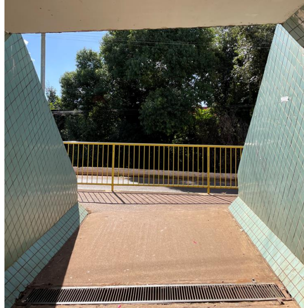
FIGURA 6.72 – GUARDACORPO DE PROTEÇÃO NA SAÍDA DA TRAVESSIA
