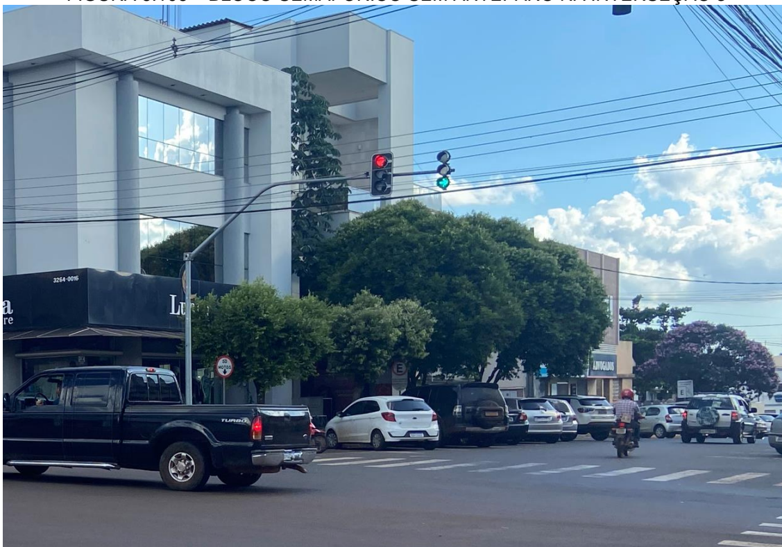
FIGURA 6.106 – BLOCO SEMAFÓRICO SEM ANTEPARO NA INTERSEÇÃO 3
