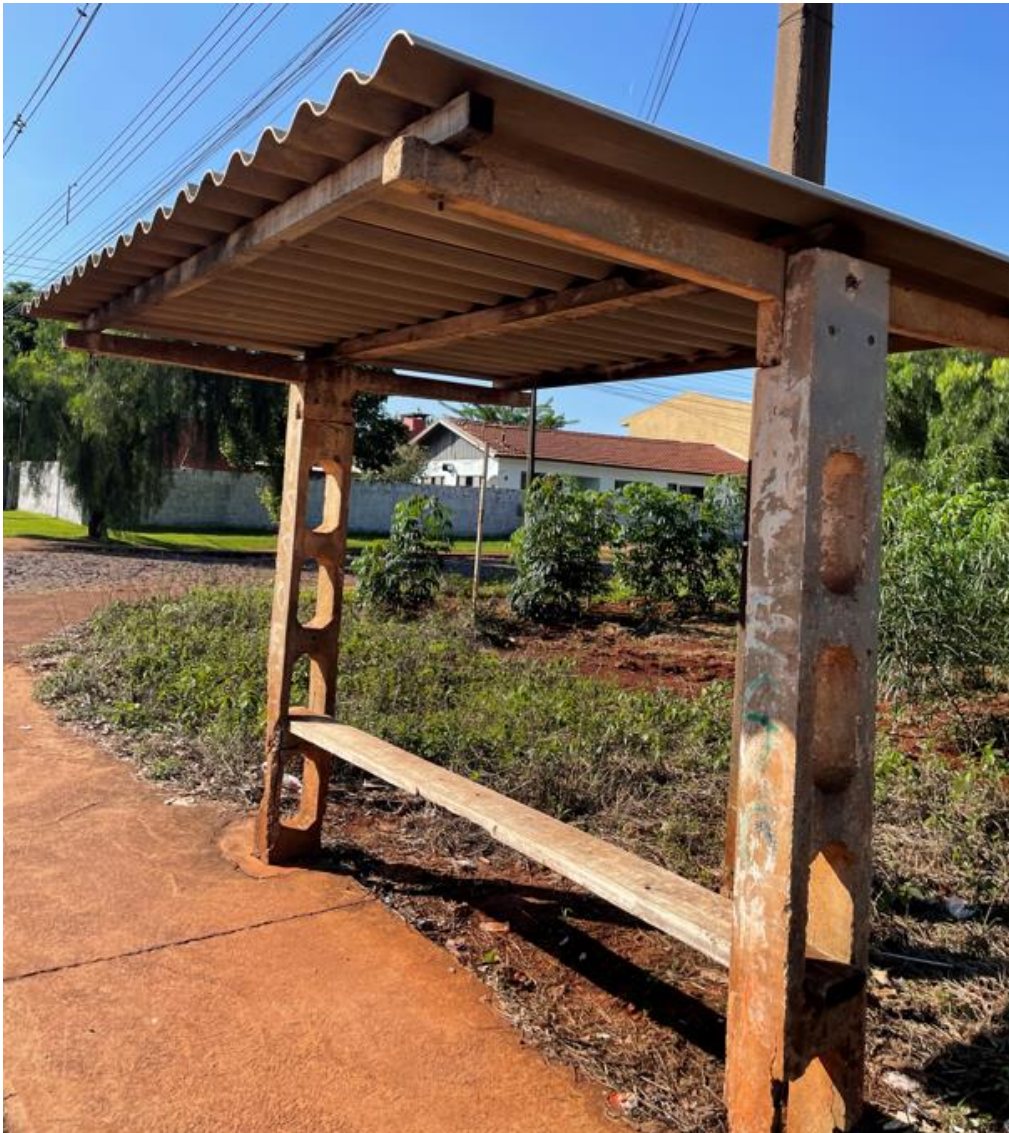
FIGURA 6.128 – ABRIGO DE CONCRETO COM COBERTURA DE ETERNIT
