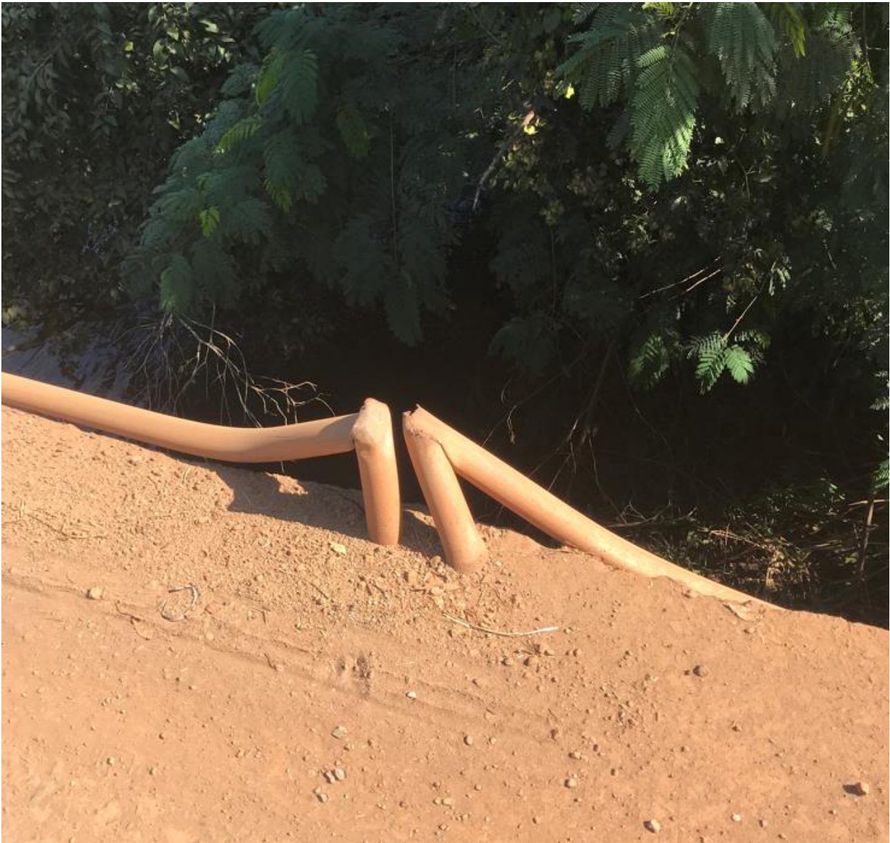
FIGURA 6.88 – GUARDA-RODAS AMAÇADO
