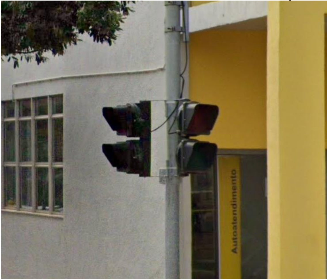
FIGURA 6.108 – SEMÁFOROS DE PEDESTRE DESATIVADOS NA INTERSEÇÃO 4
