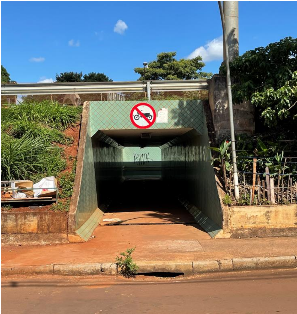
FIGURA 6.76 – VISTA FRONTAL – TRAVESSIA INFERIOR 2 – IPÊ
