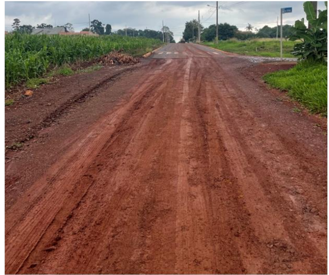
FIGURA 6.4 – FOTOGRAFIAS DE VIAS COM REVESTIMENTO EM ESTADO INEXISTENTE E RAZOÁVEL
