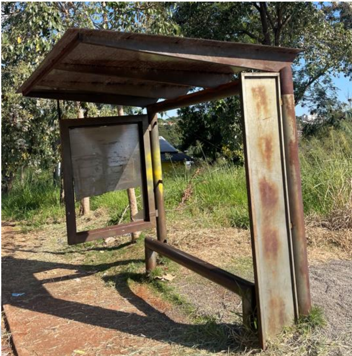
FIGURA 6.125 – ABRIGO DE METAL
