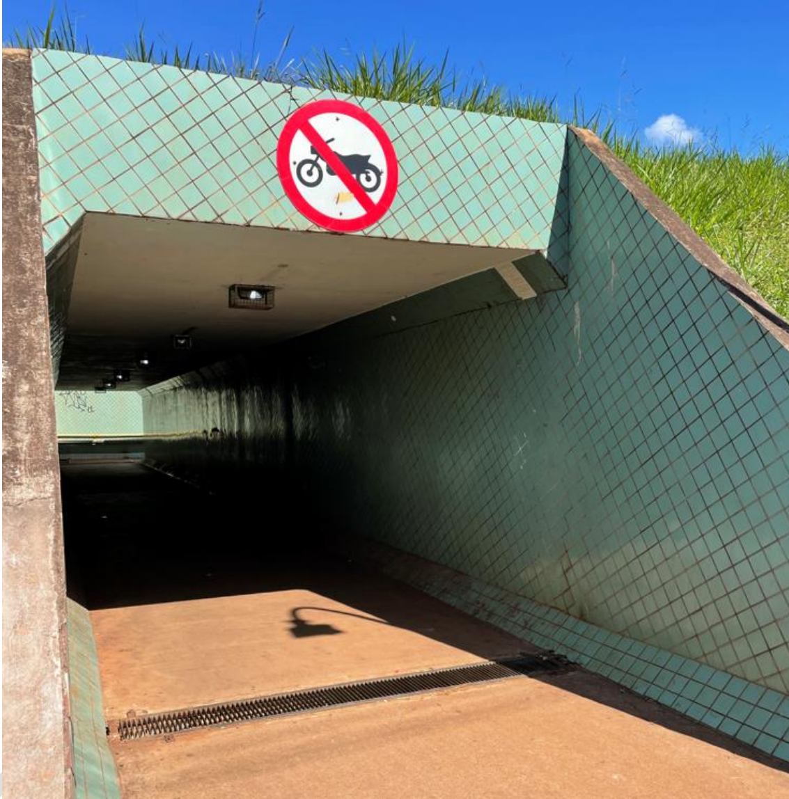
FIGURA 6.70 – VISTA FRONTAL – TRAVESSIA INFERIOR FRIMESA
