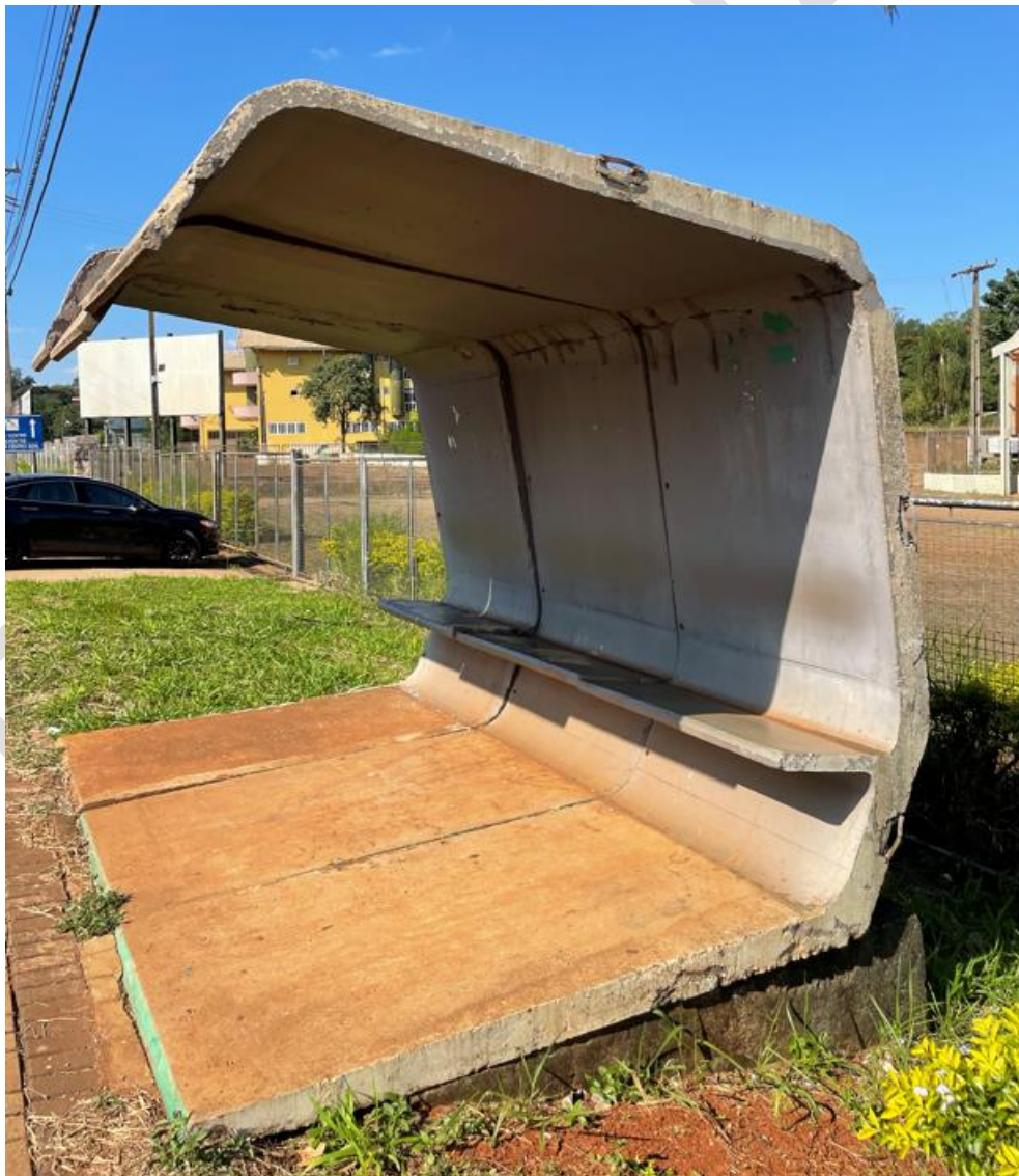
FIGURA 6.124 – ABRIGO NEW JERSEY
