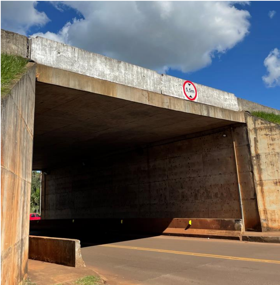
FIGURA 6.82 – VISTA DO ENCONTRO – TRINCHEIRA BELO HORIZONTE/IPÊ
