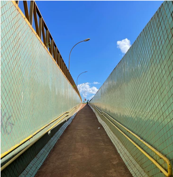
FIGURA 6.71 – RAMPA DE ACESSO À TRAVESSIA
