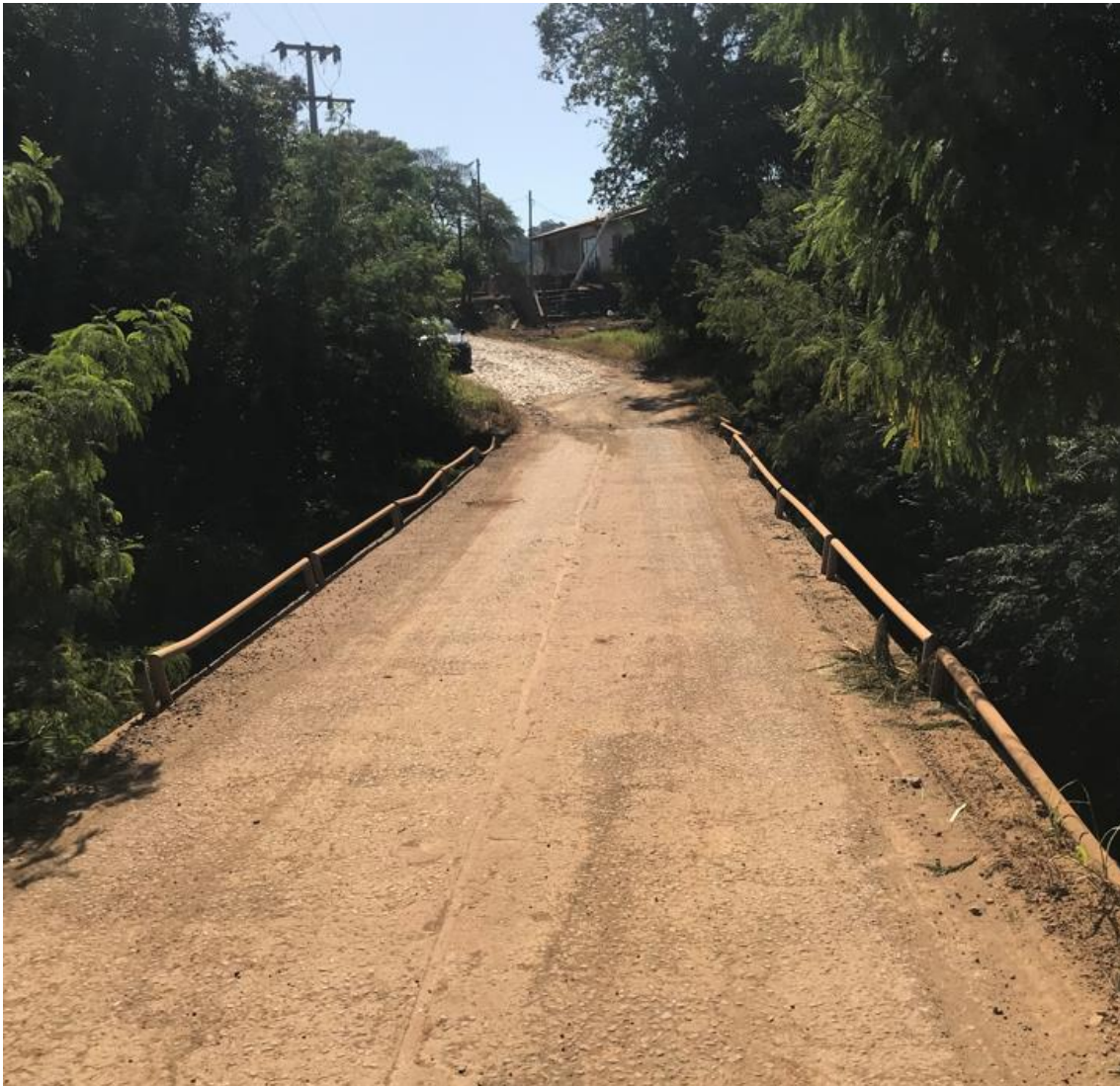
FIGURA 6.87 – VISTA SUPERIOR - PONTE SOBRE O RIO OURO VERDE 2
