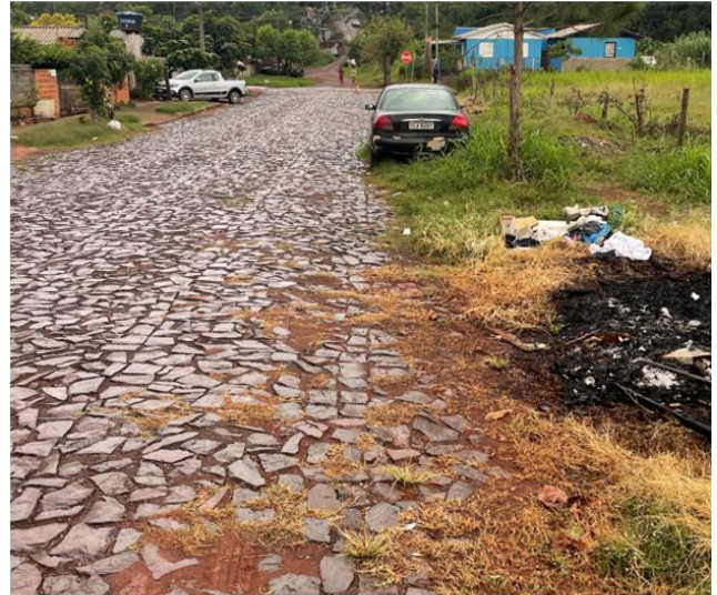
FIGURA 6.5 – FOTOGRAFIAS DE VIAS COM REVESTIMENTO EM ESTADO SUJO E BOM
