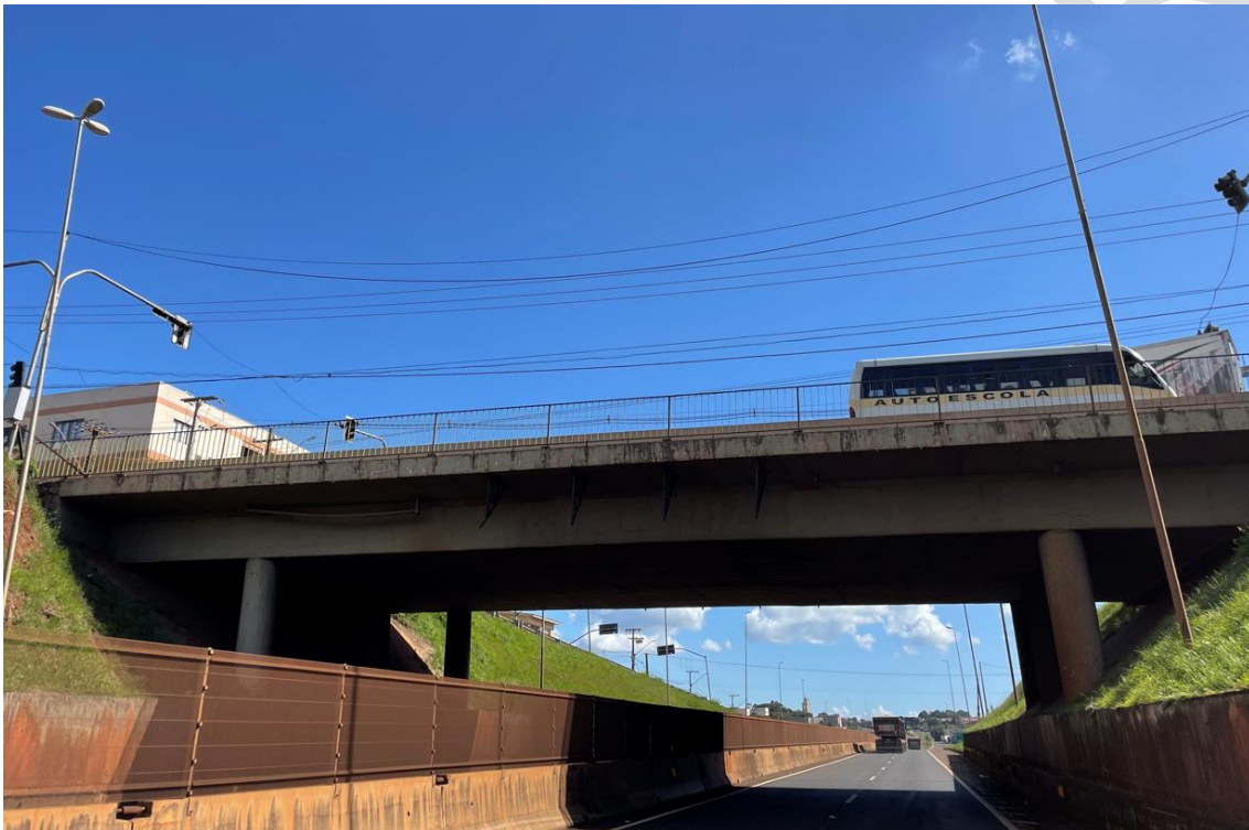
FIGURA 6.74 – VISTA LONGITUDINAL – VIADUTO AVENIDA BRASÍLIA
