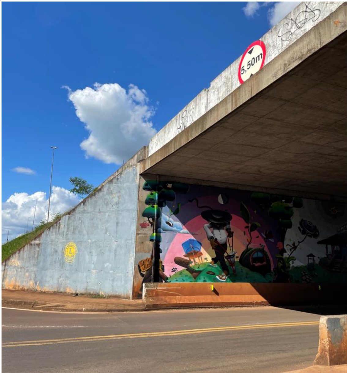
FIGURA 6.69 – VISTA DO ENCONTRO – TRINCHEIRA FRIMESA
