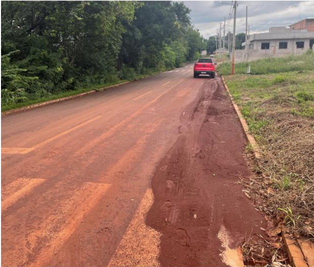
FIGURA 6.5 – FOTOGRAFIAS DE VIAS COM REVESTIMENTO EM ESTADO SUJO E BOM
