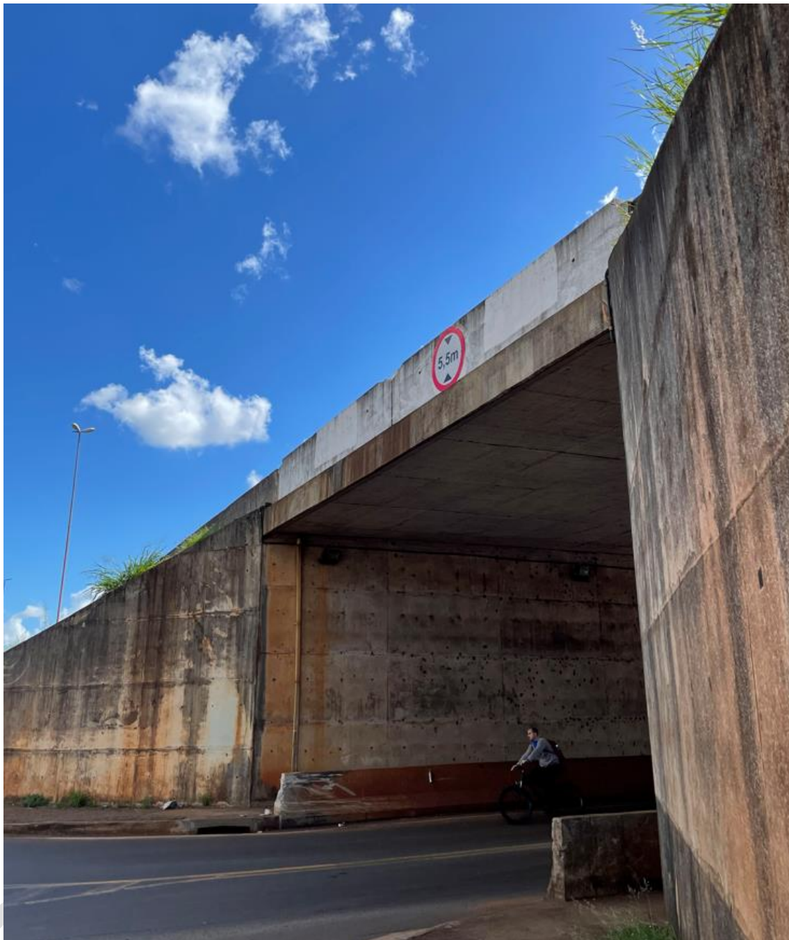
FIGURA 6.84 – VISTA DO ENCONTRO – TRINCHEIRA ÁREA INDUSTRIAL
