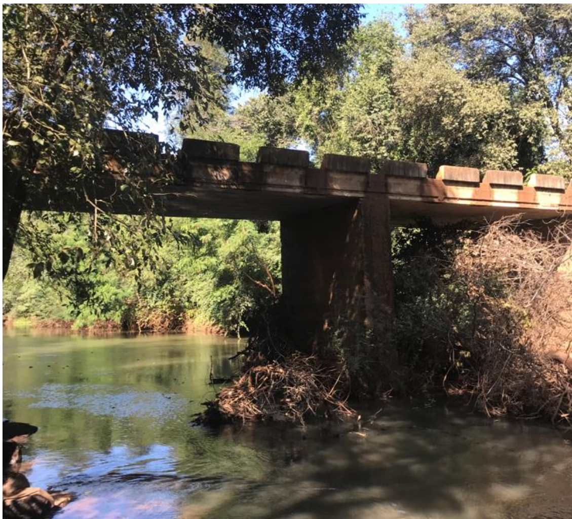
FIGURA 6.86 – VISTA LONGITUDINAL - PONTE SOBRE O RIO OURO VERDE
