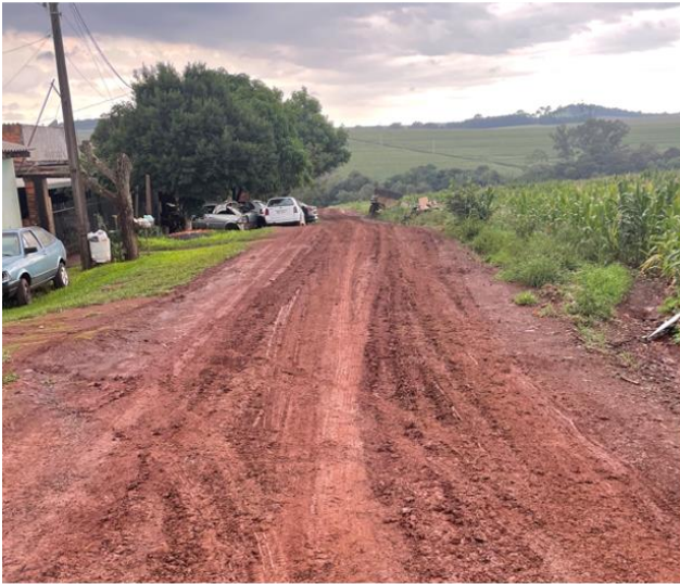
FIGURA 6.4 – FOTOGRAFIAS DE VIAS COM REVESTIMENTO EM ESTADO INEXISTENTE E RAZOÁVEL
