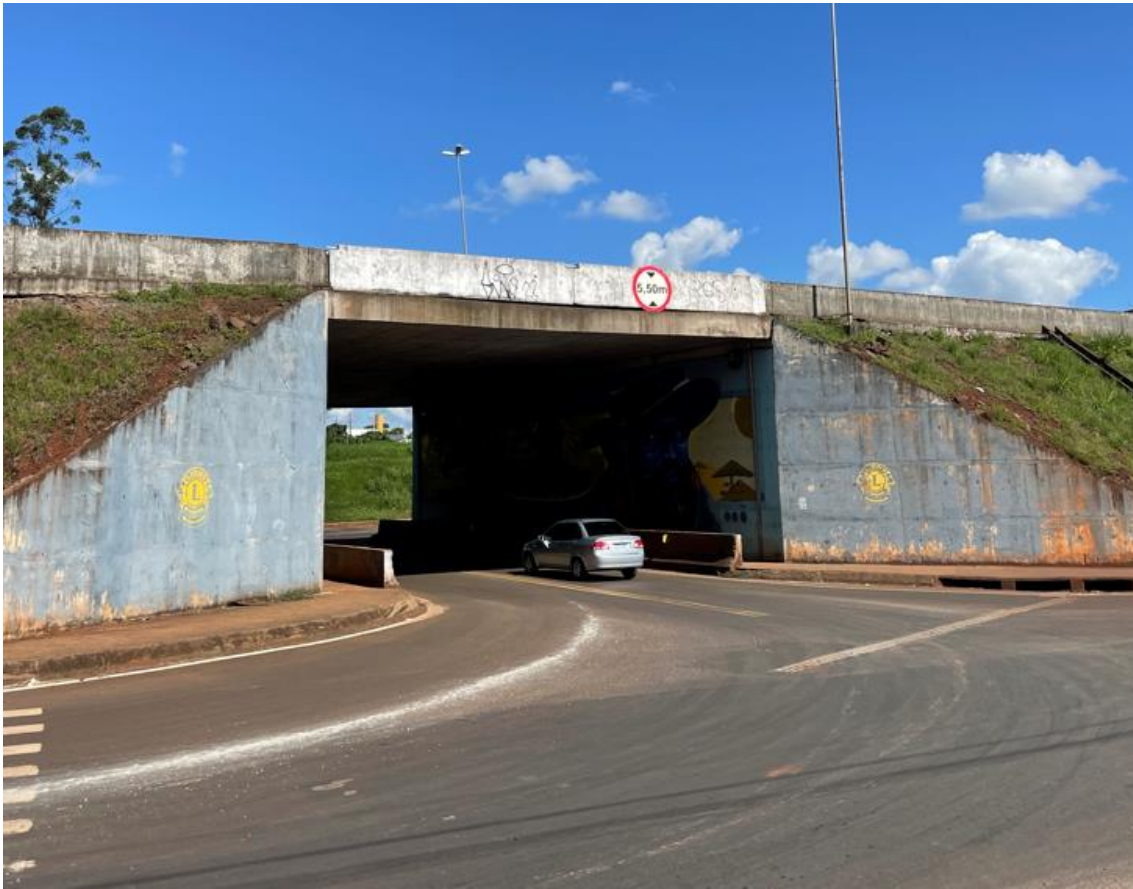
FIGURA 6.68 – VISTA FRONTAL – TRINCHEIRA FRIMESA
