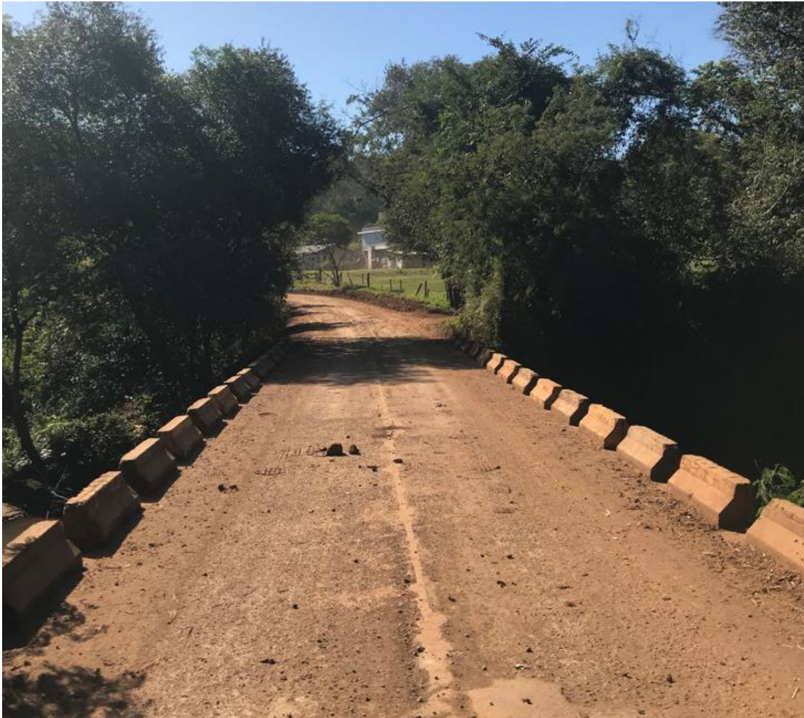
FIGURA 6.85 – VISTA SUPERIOR - PONTE SOBRE O RIO OURO VERDE
