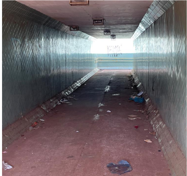
FIGURA 6.78 – SUJEIRAS NA TRAVESSIA
